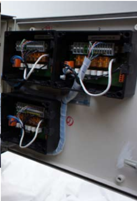
Styreskap med PLS og releer. Her bearbejdes alle innkommende data fra måleenhetene. Signalene definerer kjettingtaljen og løpekattens bevegelse og posisjoner.
